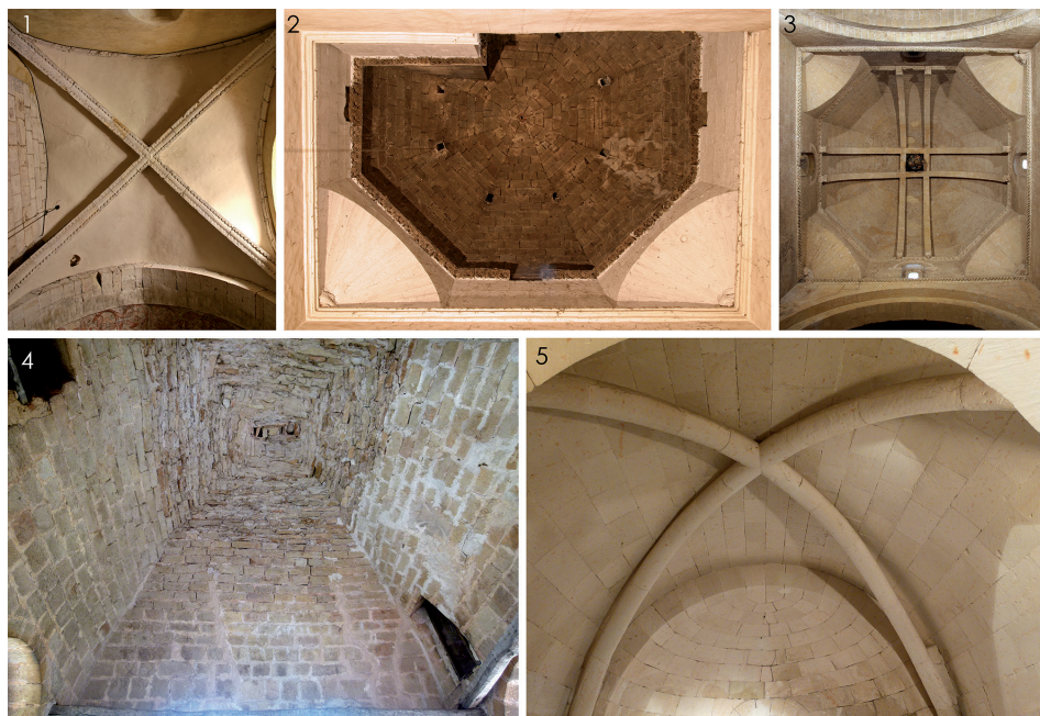
FIGURA 3. 1. Bóveda de crucería en el ábside sur de San Clemente (Segovia); 2. Cúpula ochavada en la torre de San Esteban (Segovia); 3. Bóveda de arcos cruzados en el crucero de San Millán (Segovia); 4. Bóveda esquifada en la torre de Nuestra Señora de la Peña (Sepúlveda); 5. Bóveda de crucería en la cripta de la iglesia de los Santos Justo y Pastor (Sepúlveda). 1, 2 y 3 fotografías de la Enciclopedia del Románico . 3 y 4 fotografías de la autora.
