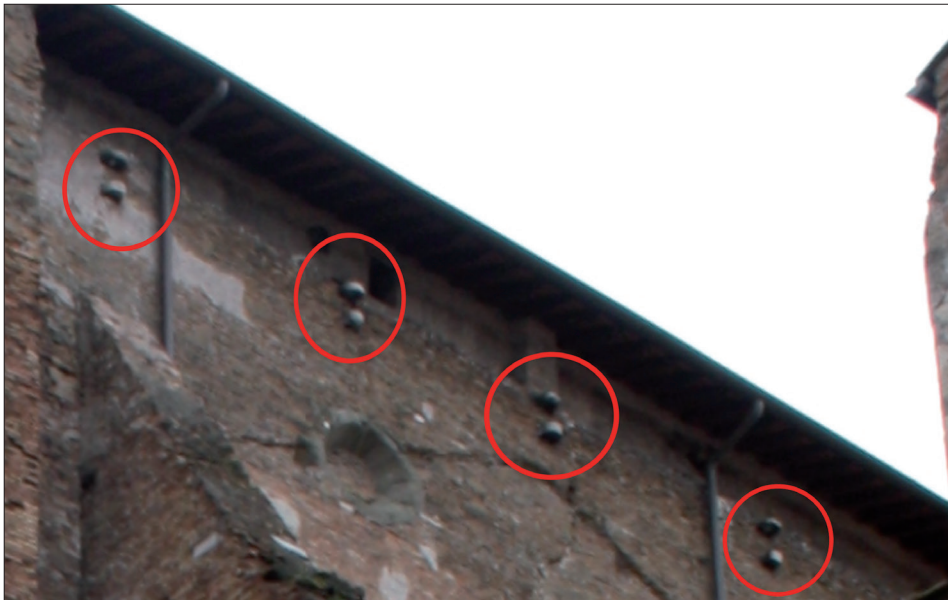
FIG. 6 SS. Quattro Coronati, particolare della Torre Maggiore. In evidenza gli anelli e mensole porta stendardo.
