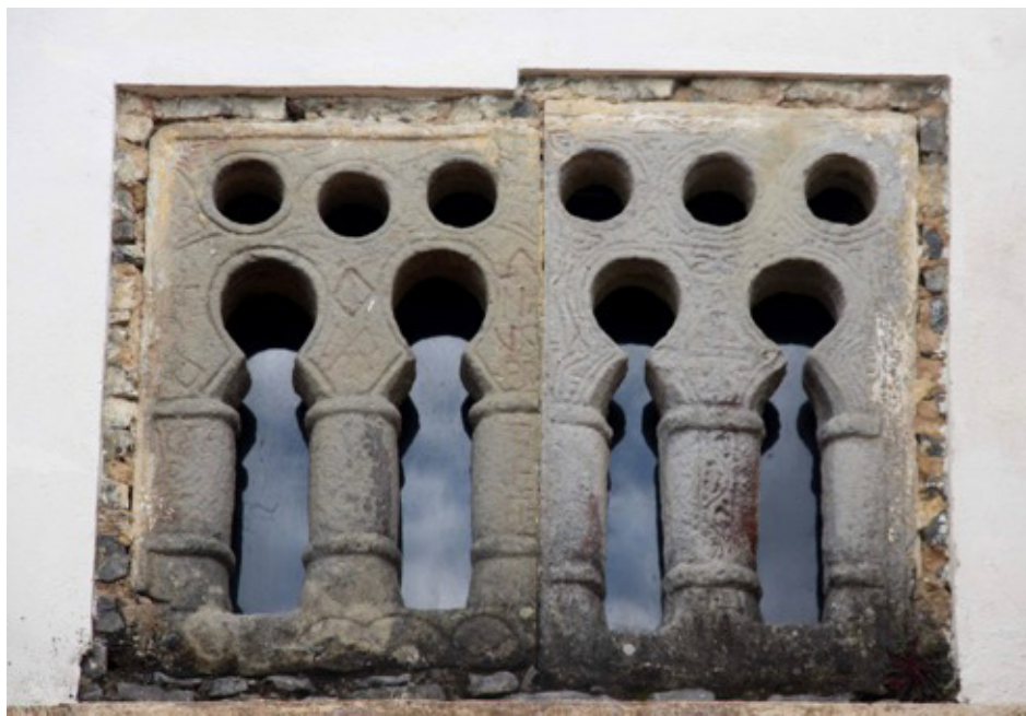
FIGURA 9. Ventanas monolíticas de Santiago de Sariego (Sariego).
