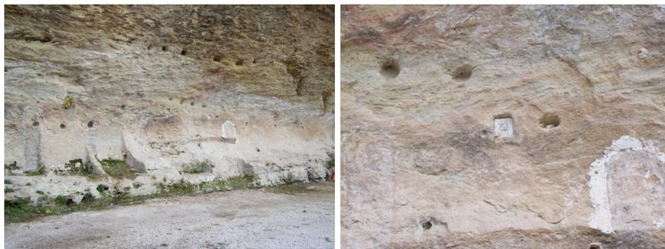
**Figura 13-14.** Vista de los restos de alгорines (trojes) que se conservan del antiguo Molino de la Cueva, y de los distintos hoyos de postes o vigas en la pared de calcarenita bioclástica, característica de la formación geológica de la Tranca. Detalle de alгорín que conserva el número que tenía asignado.
