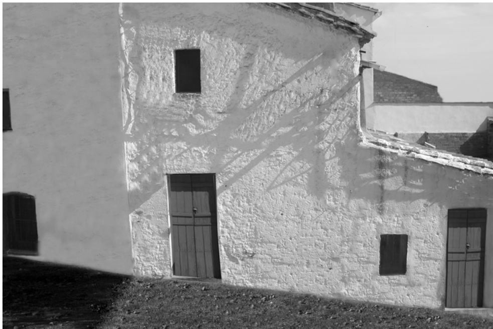
Fotografía 2. Casas del barrio morisco o barrio nuevo de Almadén. Fuente: García-Rayo, 2021
