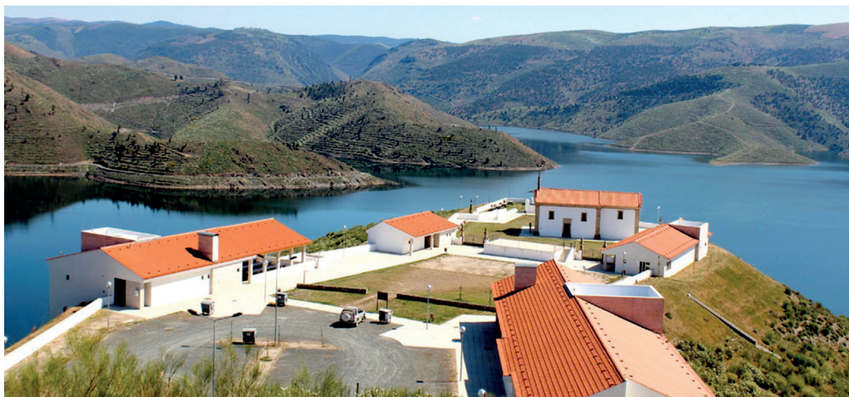
FIG. 10. Actual emplazamiento del santuario da Santo Antão da Barca, en Parada, Alfândega da Fé, sobre los Lagos do Sabor.
