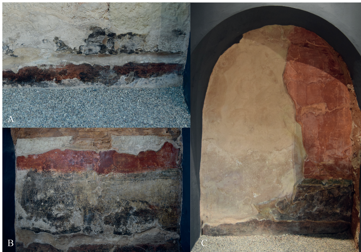
FIG. 7. A) Restos de zócalo de la Estancia 2 en el muro oeste con presencia de trazo inciso en el zócalo de la primera fase; B) restos de zócalo y zona media en el muro oeste; C) restos de zócalo y zona media en el muro norte.
