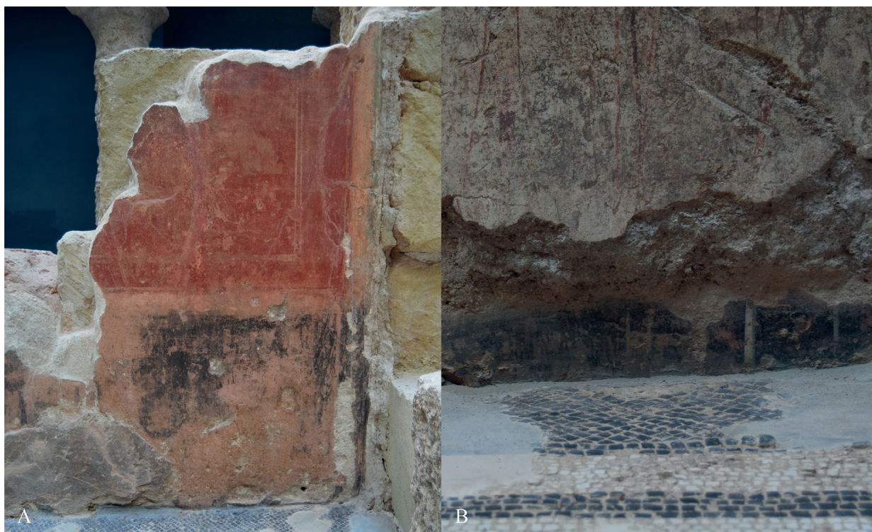
FIG. 4. A) Placa conservada en el muro sur del triclinium correspondiente a la Fase 1; B) detalle del zócalo de la Fase 1 bajo el zócalo de la Fase 2.
