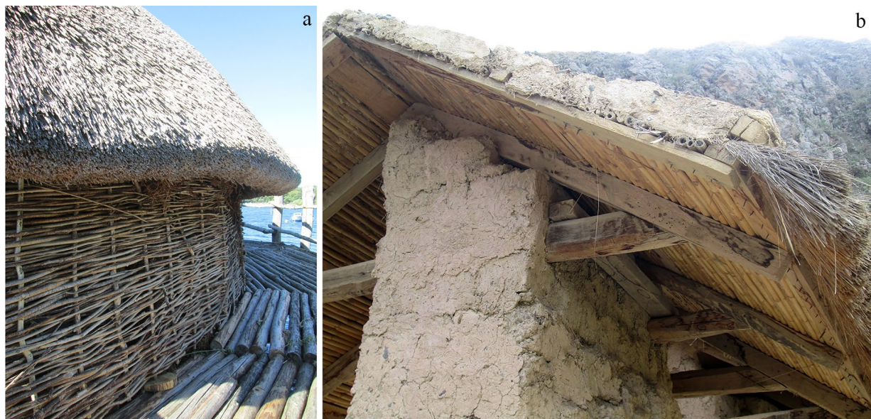
FIG. 13. a) Pared experimental de vegetales entrelazados en Scottish Crannog Centre, Kenmore, Reino Unido. b) Cubierta con gruesa "torta" de barro sobre elementos vegetales en Ollantaytambo, Perú.
