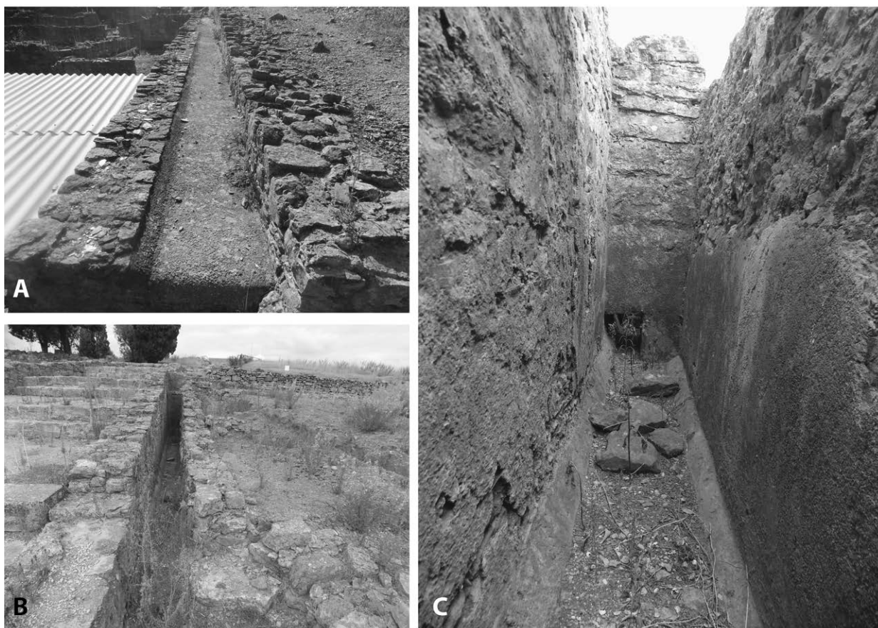
FIG. 17. Paredes dobles en Mirobriga: A) Termas Este ; B) Edificio A , en el lado O, delimitado por las escaleras de la vía XI; C) Edificio A , interior del lado N.
