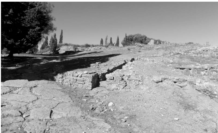
FIG. 15. Canal encargado del drenaje del de la plaza del foro mirobrigense (arriba dcha.) y su punto de vertido junto a la vía IV (izqda.).
