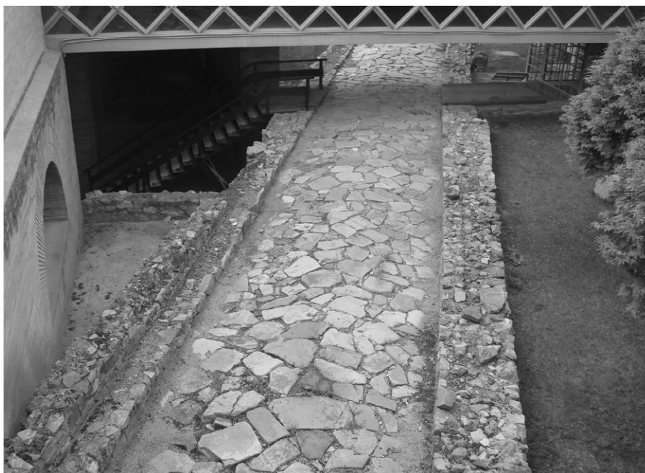
FIG. 5. Aterrazamiento y muros laterales en la calzada extramuros conservada en el Museo Nacional de Arte Romano de Mérida.
