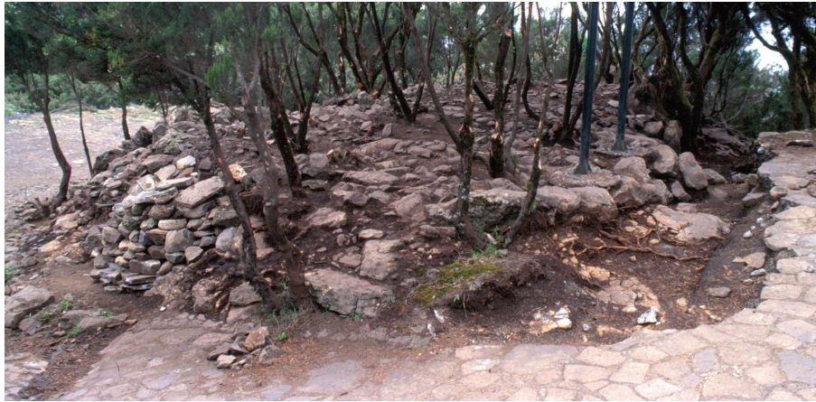
FIG. 3. Vista general de la Estructura A.
