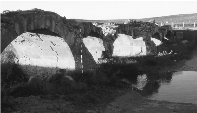
LÁM. 6. Puente de Aldealhama.
