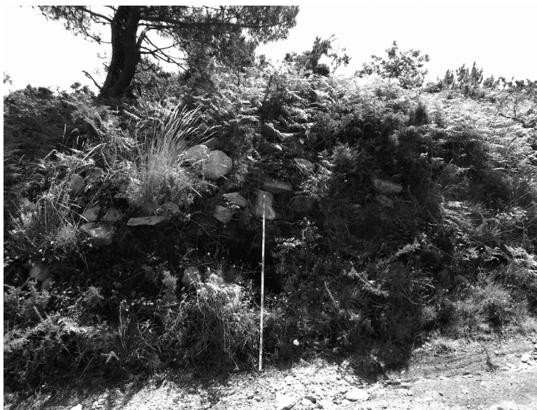
FIG. 7. Vista actual del corte en el Terraplén 2.
