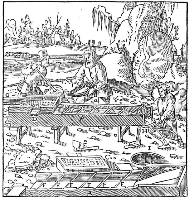
FIGURA 2. Canal de lavado de oro, según AGRÍCOLA (1972, VIII, fig. p. 33A). A: Canalón (Canalis). B: Caja de cabecera sobre la que se echa el mineral (Cansa). C: Fondo de la caja invertida (Eiusdem inversae fundum). D: Lado abierto de ella (Eiusdem pars patens). E: Azada de hierro (Rutrum Ferreum). F: Tabloncillos transversales a modo de riffles (Tabellae). G: Canalillo de abastecimiento de agua (Canaliculum). H: Batea en la que se recoge el oro depositado en el fondo del canal (Alveus). I: Batea negra para lavado en fino (Alveus niger).
