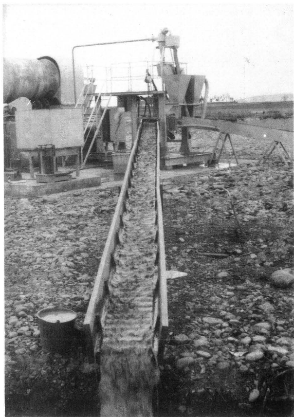
FOT. 1. Canal de lavado o sluice de la planta-piloto de R.T.M. en Castrillo de la Valduerna, en funcionamiento.
