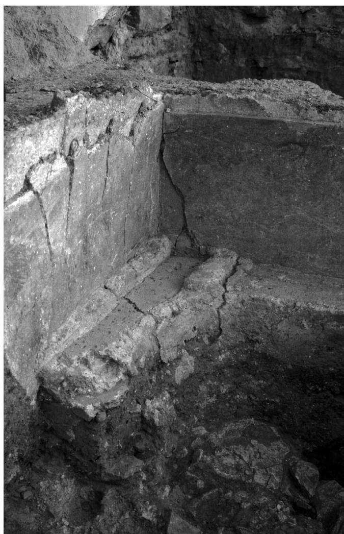
FIG. 10. Detalle de la fábrica de la bañera revestido de mortero con una capa pictórica blanca.
