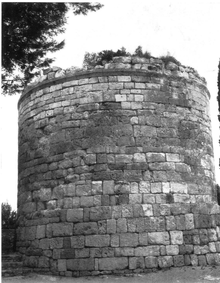
FIG. 2. La «torre de Les Gunyoles». Estado actual (1974).
