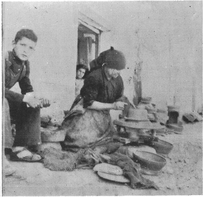
Fotos 1, 2 y 3: Proceso de levantar el borde de una cazuela. En la foto 3 se puede ver una lusia preparada al pie de la alfarera, para la próxima pieza. Foto 4: La alfarera anidiando una cazuela con el jañadero .
