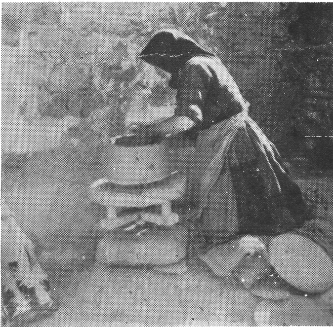
Fotos 1, 2 y 3: Proceso de levantar el borde de una cazuela. En la foto 3 se puede ver una lusia preparada al pie de la alfarera, para la próxima pieza. Foto 4: La alfarera anidiando una cazuela con el jañadero .
