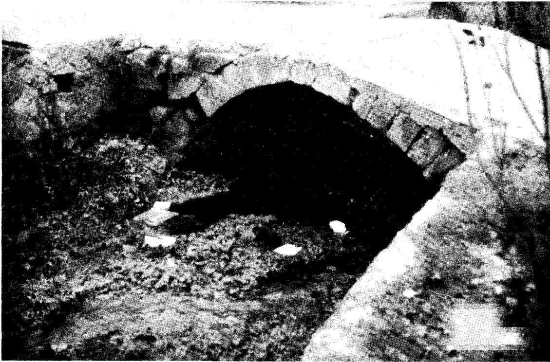
Lámina IX. Alcantarilla de Sajazarra.
