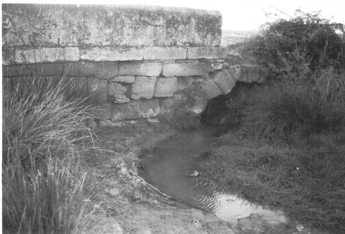
Lámina II. Alcantarilla de Ventas de Valpierre.
