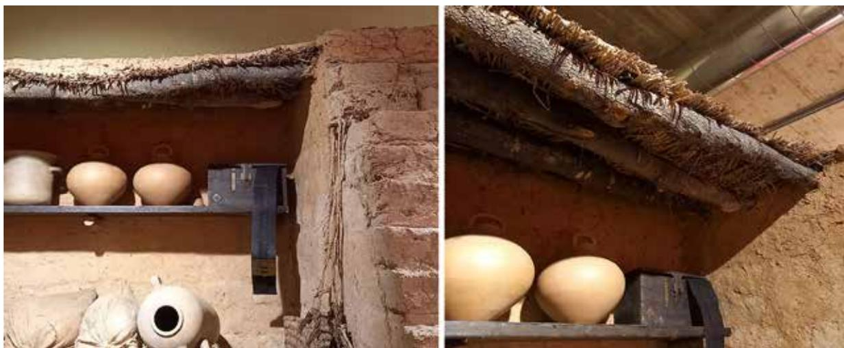
FIG. 14. *Reconstrucción de una casa ibérica (Recinto 2), con cubierta compuesta por una gruesa capa de barro y alzados de adobe, del asentamiento de Font de la Canya en el centro de interpretación CO Vinífera, Avinyonet del Penedès, Barcelona.*
