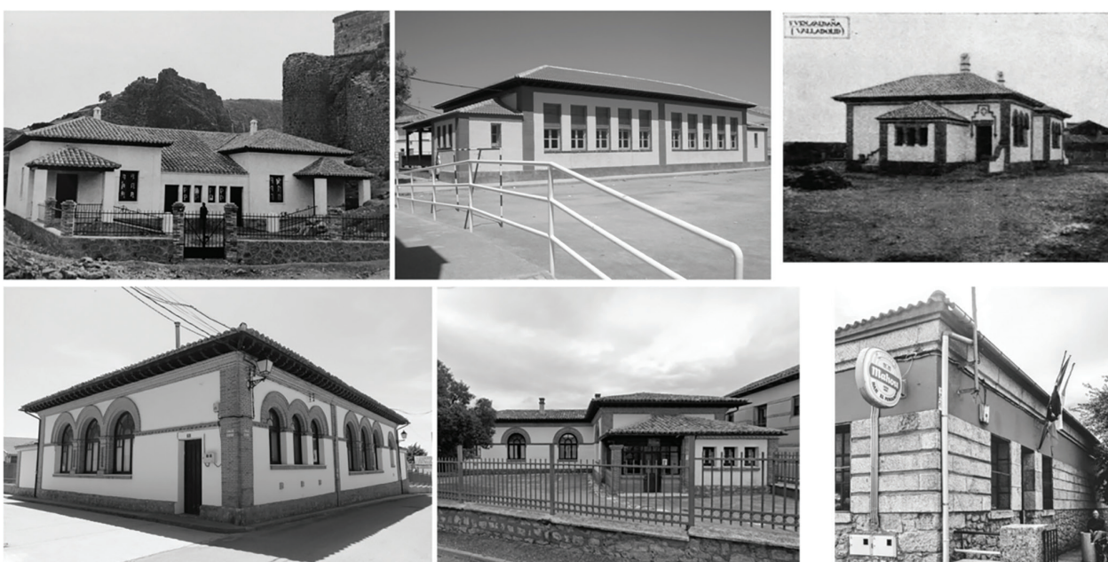
Figura 9. Escuelas construidas en: a) Cañete (Cuenca, 1927, Muro), b) Castejón de los Monegros (Huesca, 1927, Muro), c) Fuensaldaña (Valladolid, 1925, Muro), d) y e) Villafrechós (Valladolid, 1930, Muro), y f) Valverde de Valdelacasa (Salamanca, 1933, Muro)
