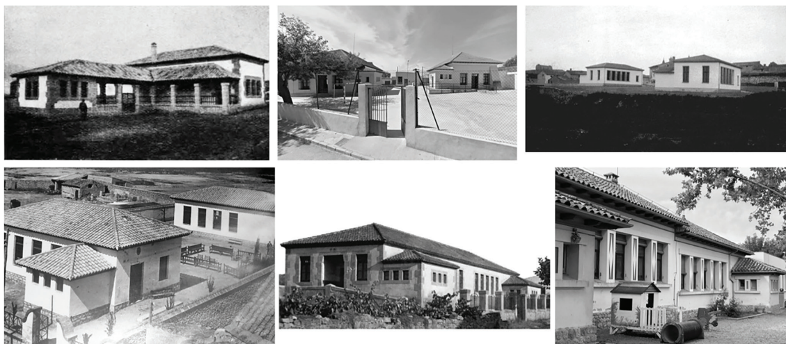
Figura 6. Escuelas construidas en: a) Sauquillo de Boñices (Soria, 1925, Muro), b) Turleque (Toledo, 1925, S. Sepúlveda), c) Monegrillo (Zaragoza, 1931, Pezuela), d) Nuez de Ebro (Zaragoza, 1923, S. Sepúlveda), e) Solivella (Tarragona, 1927, Gallegos) y f) Guialbes (Gerona, 1930, Gallegos)
