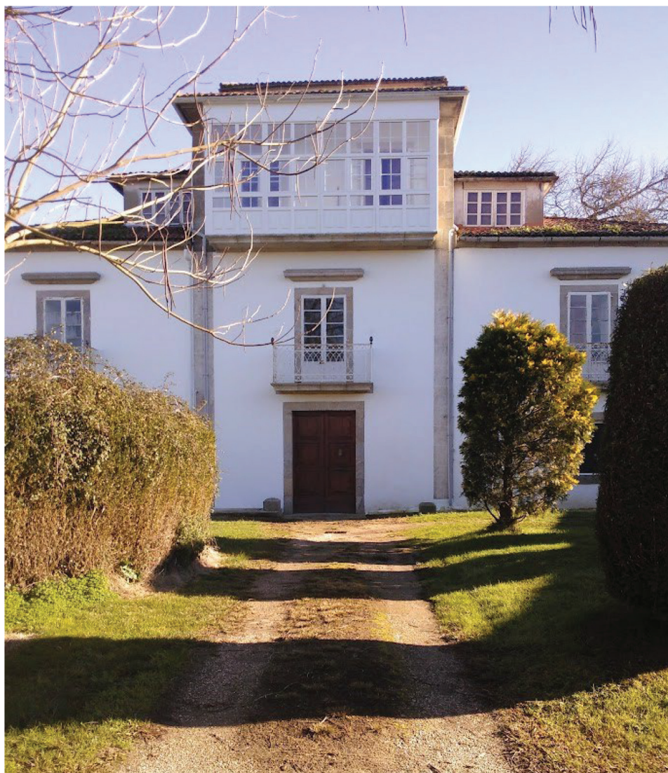
Imagen 3. Fachada del Pazo de San Fiz de Vixoi (Bergondo, A Coruña). 3 de enero de 2019. Foto de los autores
