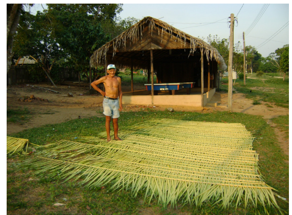
Imagem 3. Uso da palha para construções de residências na comunidade Cachoeira do Aruã, região do rio Arapiuns. Fonte: acervo dos autores.
