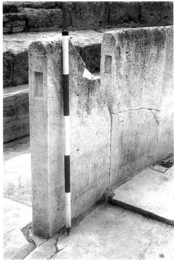
FIG. 21. Losas del balteus, tipo 3; nótese el recurso de *anathyrosis* a fin de asegurar la unión entre las piezas.
