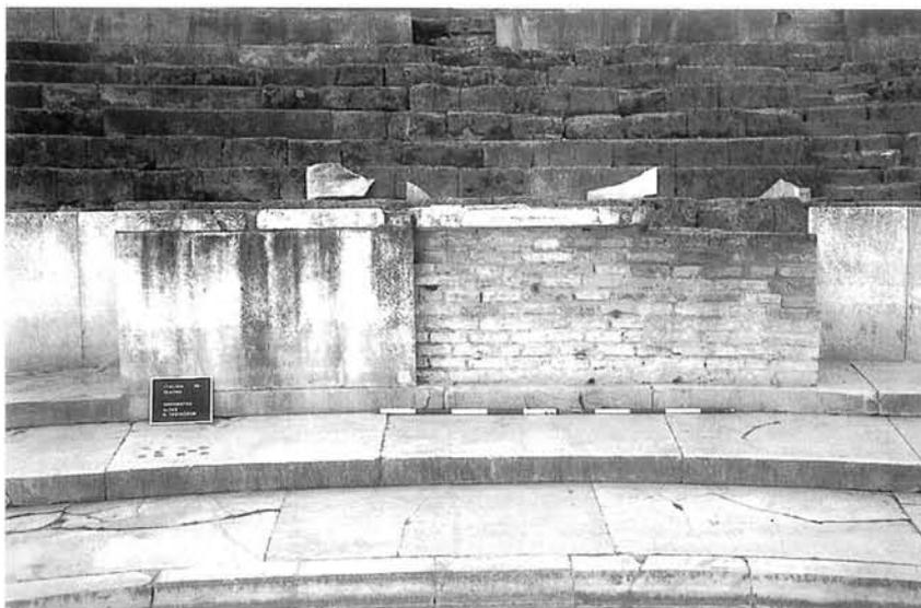
FIG. 12. Estructura de opus testaceum.
