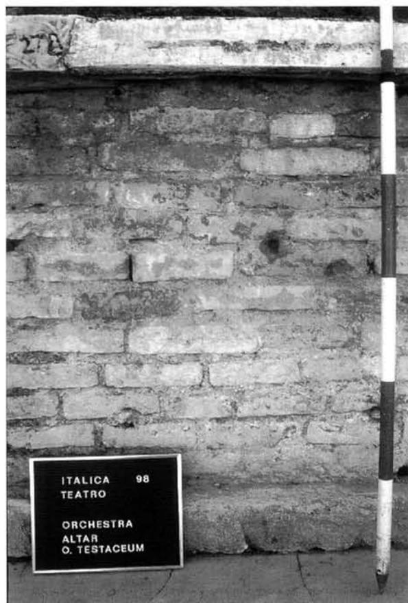
FIG. 15. *Detalle de la fábrica de opus testaceum de la estructura sobre la proedria. En ella se aprecian las cavidades para el anclaje de las placas mármóreas que cubrían sus paramentos externos.*
