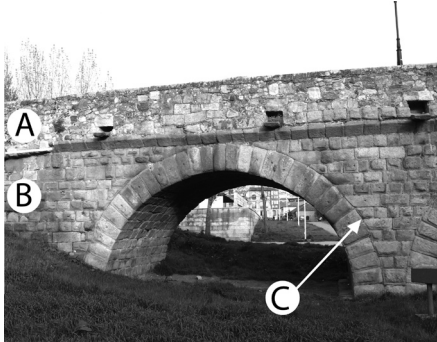
Figura 7. Primer arco del Puente Romano de Salamanca. (A) Parte inferior granítica con clara fractura romana y (B) la parte superior realizada con sillares de la Arenisca de Salamanca y algunos de granito. (Fotografía de J. Bécares, 2011).
