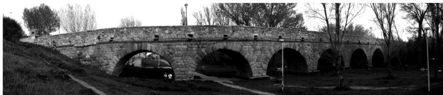
Figura 6. Siete de los quince arcos de fábrica romana del Puente Romano de Salamanca (Fotografía de J. Bécares, 2011).
