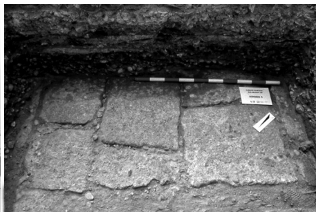
Figura 4. Estructura interna del Puente Romano observada durante la reparación realizada en 1999 gestionada por el ayuntamiento de Salamanca.
