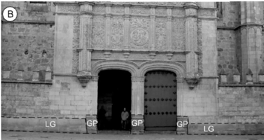
Figura 12. Escuelas Mayores con la restauración antigua de leucogranito turmalínífero. a) Fotografía tomada por J. Martínez Hebert (FALCÓN, 1867); b) Fotografía actual mostrando la restauración posterior a 1867 con leucogranito turmalínífero (LG) flanqueando al granito porfídico central (GP).
