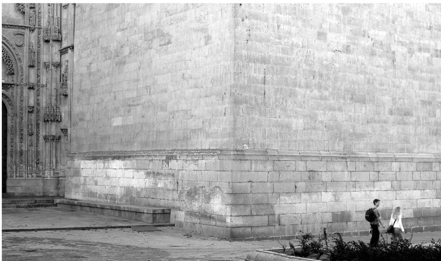
*Figura 11. Refuerzo externo en la torre de la Catedral Nueva con ocho hiladas de bloques de leucogranito turmalinífero.*
