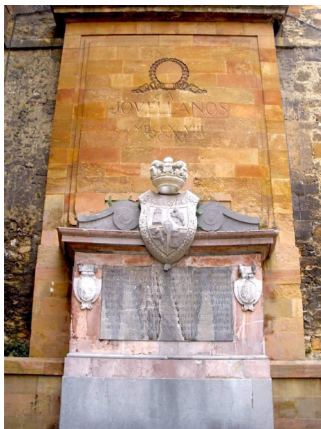
Imagen 2: Estado actual del monumento (fuente propia).
