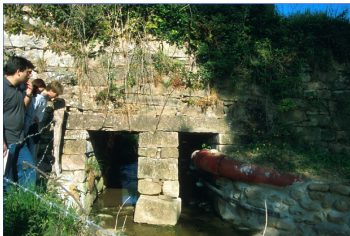
Figura 4. Obras de drenaje transversal en el Real Camino a su paso por Molledo (MRB).
