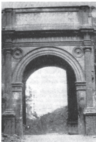
Figura 5. Vista de la magnífica portada renacentista del Palacio de los Duques de Híjar justo antes de su desmontaje en 1912.
