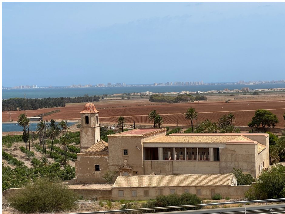
Figura 1. Convento de San Ginés de la Jara (Cartagena): estado actual de las obras de restauración. (Fuente: pmcavero).
