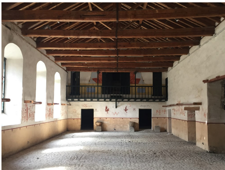
Fig. 7. Interior del rancho de Cabanillas del Monte, único edificio conservado. Se observa la galería volada donde los propietarios se asomaban a contemplar las tareas, así como la gran puerta central tras la cual se situaba el oratorio de la casa. Fotografía de los autores.
