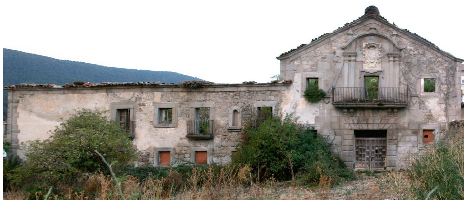
Fig. 14. Fachada y puerta principal del esquileo del marqués de Perales, en El Espinar, donde se observa la calidad de la fábrica. Fotografías de los autores.
