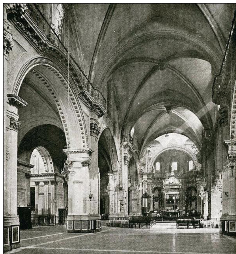
Fig. 5. Vista del interior de la Catedral de Valencia justo antes de la restauración de la década de 1970. Se aprecia todavía su revestimiento interior barroco clasicista, que prácticamente solo estaba ausente en las bóvedas.
