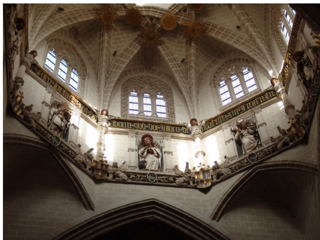
Fig. 17. Vista del interior del cimborrio de La Seo de Zaragoza. Mantiene su configuración original del primer cuarto del siglo XVI.
