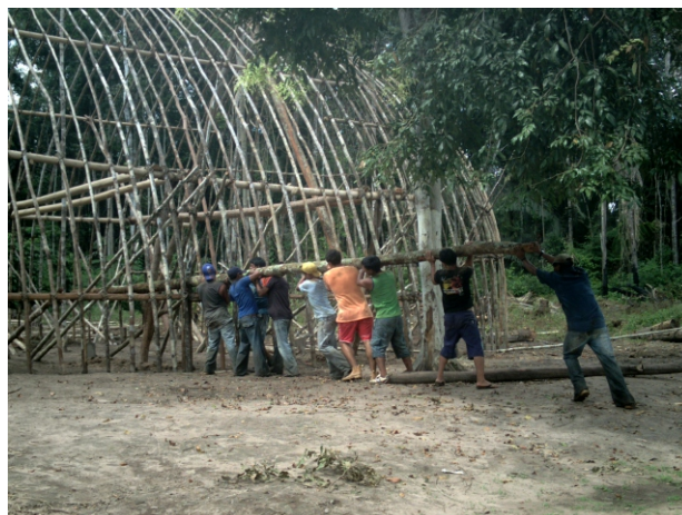
Figura 2. Levantamento do madeirame da casa,
