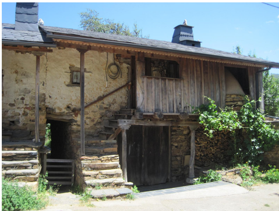
Foto n.º 2: Vivienda típica restaurada que conserva su estructura original. Fuente: wikilok.com
