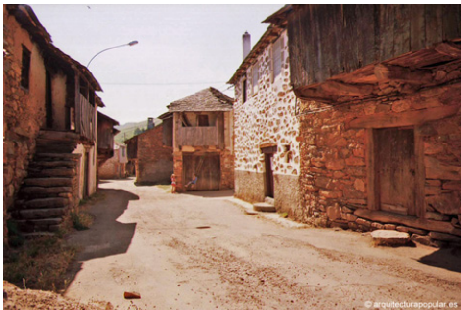
Foto n.º 1: Edificios de vivienda en la calle Real (año 1996). Fuente: arquitecturapopular.es
