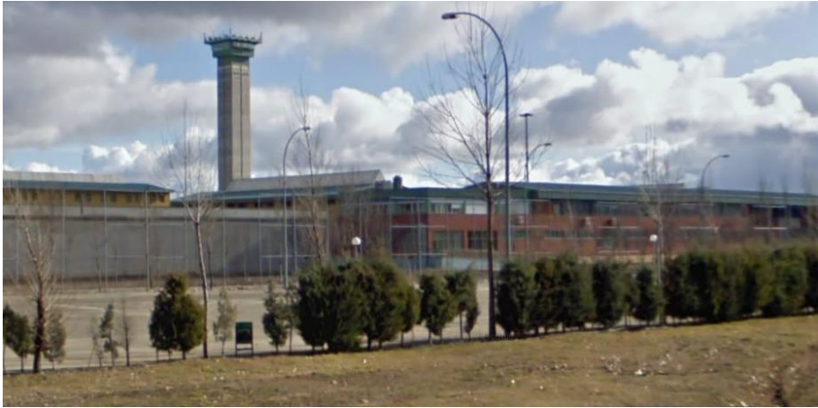
Figura 2 – Vista externa do Centro Penitenciário de Topas.
