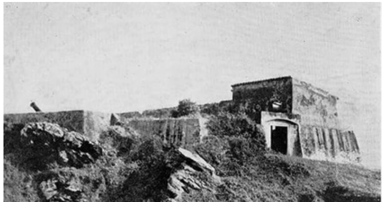
Imagem 3. Ruínas do Forte São Mateus em 1938.
