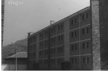
Figura 1. NOT-N-603A. Viviendas en Usera
