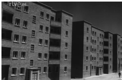
Figura 2. NOT-N-751B.Viviendas en Campomanes
