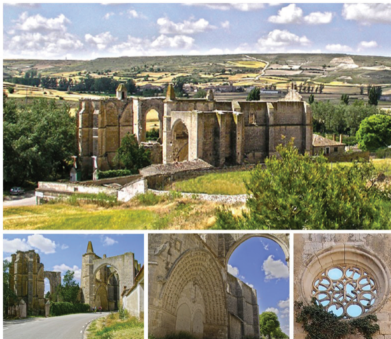
Foto 2. Ruinas góticas (s. XV) del Real Hospital y Monasterio de San Antón que la orden hospitalaria de los antonianos fundó en Castrojeriz (Burgos, España) en el año 1146. El convento disponía de un espléndido santuario y un hospital especializado en la curación del “fuego de San Antón”. En el rosetón (abajo a la derecha) se aprecia la letra Tau (T) representativa de la orden hospitalaria de San Antonio.
