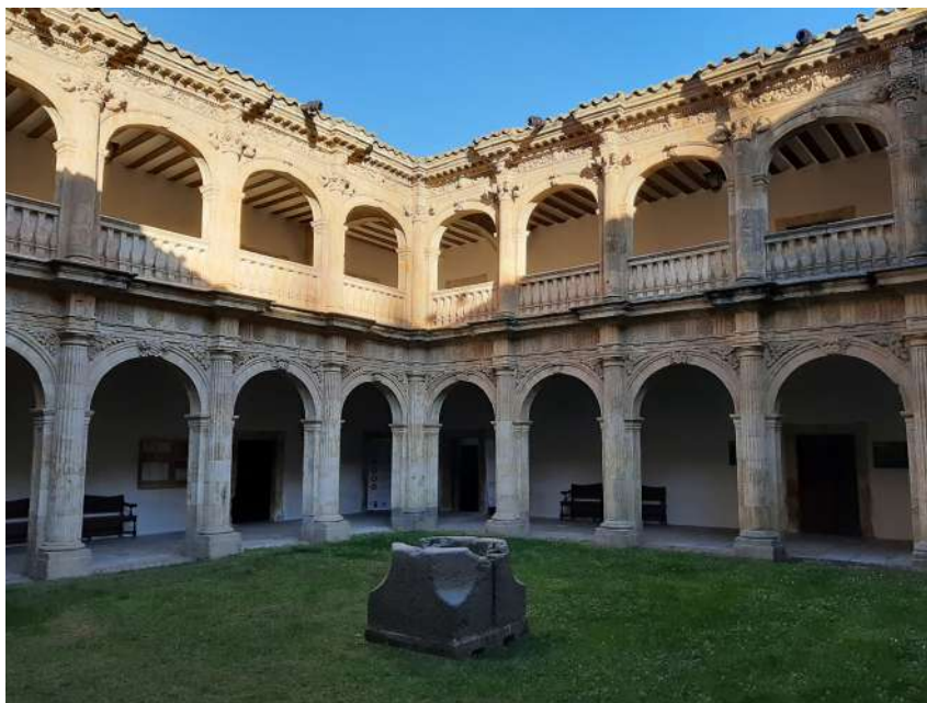
Claustro de la Hospedería de Anaya. Siglo XVIII Claustro de la Hospedería de Anaya. 18 th century
