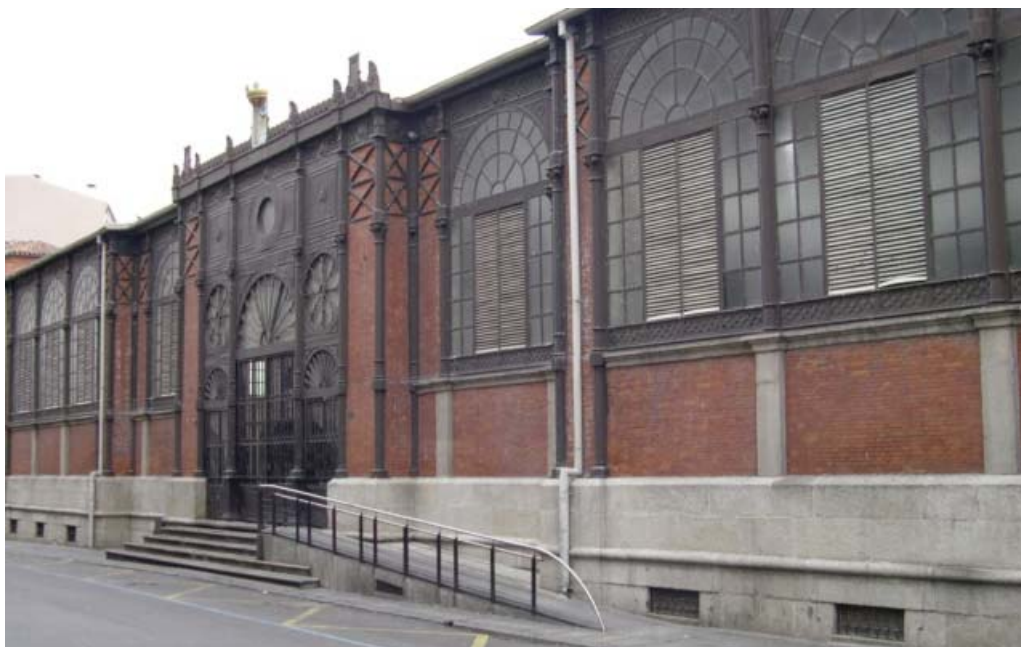
Mercado Central de Abastos de Salamanca (1899-1909). Diseñado por el arquitecto Joaquín de Vargas y Aguirre.
