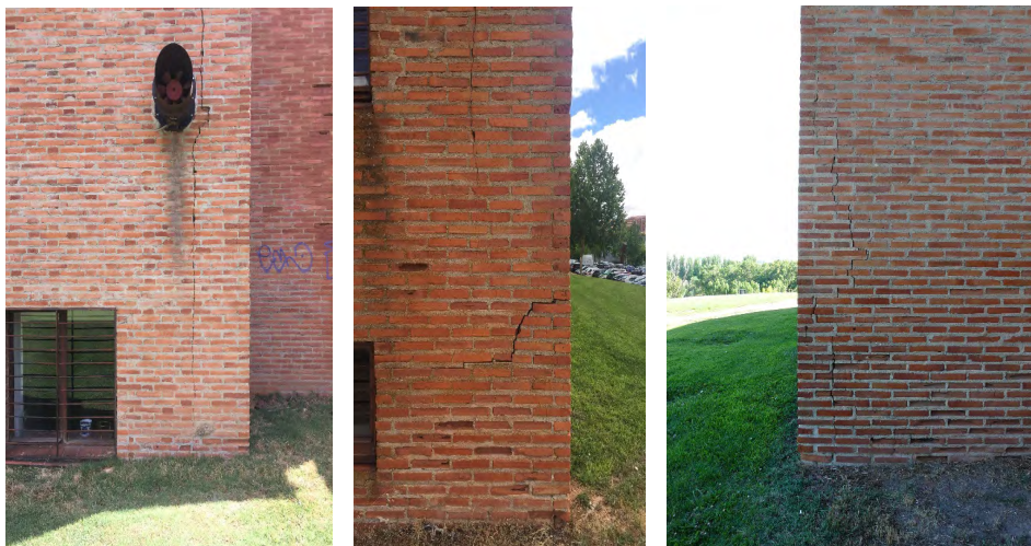
FIGURA 4. Muestra de lesiones por rotura detectadas en la Facultad de Farmacia (García, 2017).
