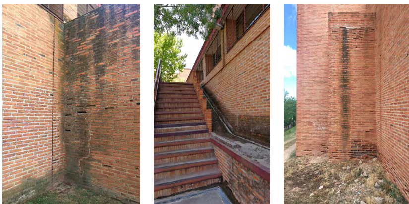
FIGURA 3. Muestra de lesiones por humedad detectadas en la Facultad de Farmacia (García, 2017).
